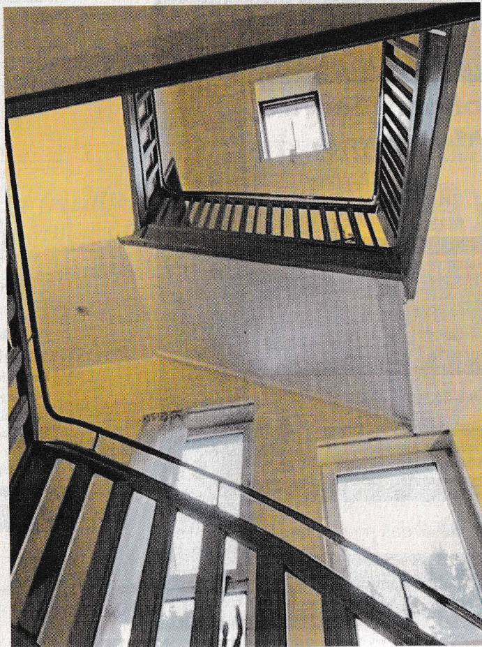
Das Treppenhaus der alten Villa. 1905 von Sanitätsrat Johannes Ide als Nordsee-Sanatorium errichtet.
