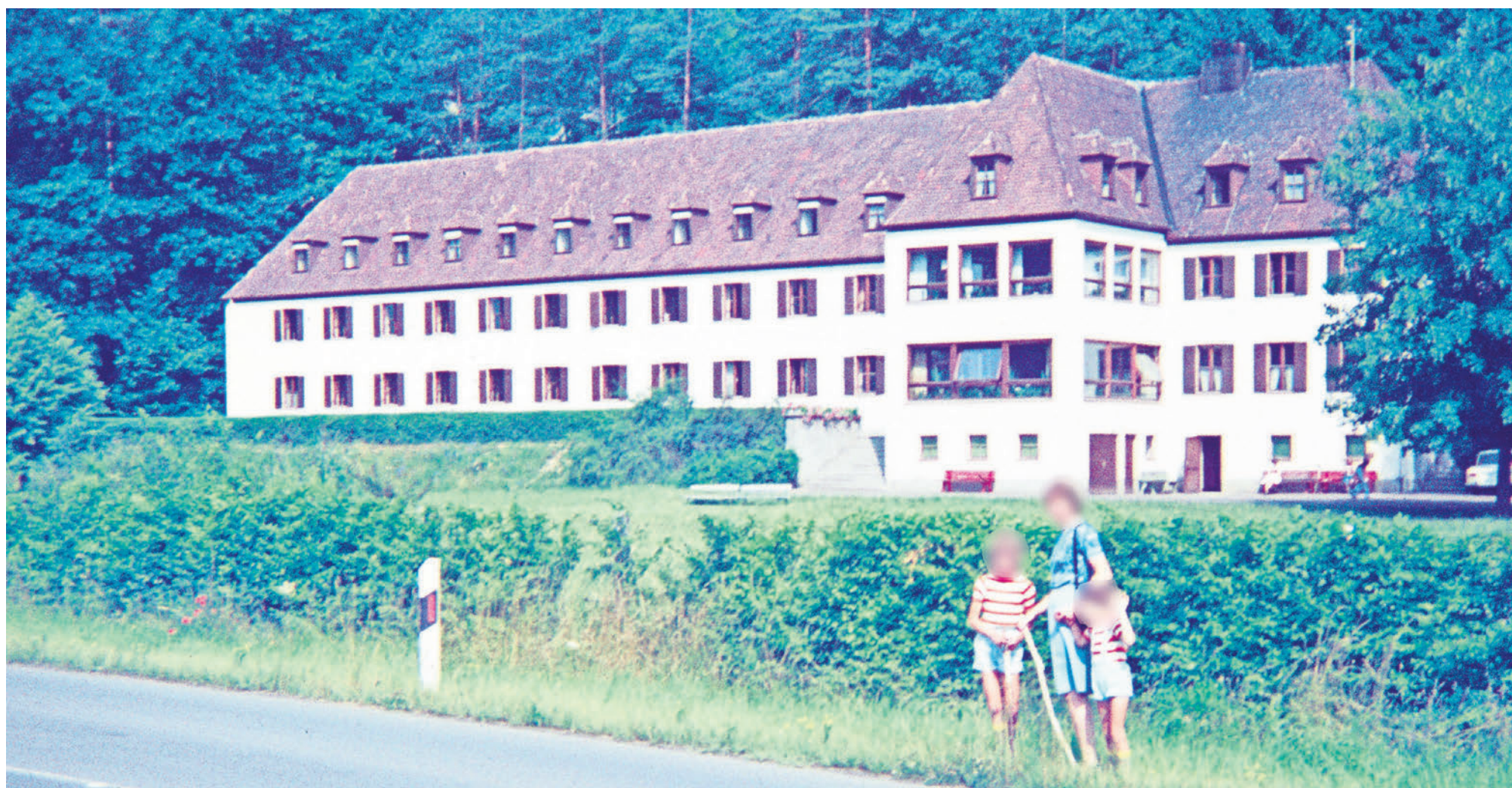
Das ehemalige Kinderkurheim in Muggendorf, wie es in den 1970er-Jahren aussah, kurz vor seiner Schließung.
