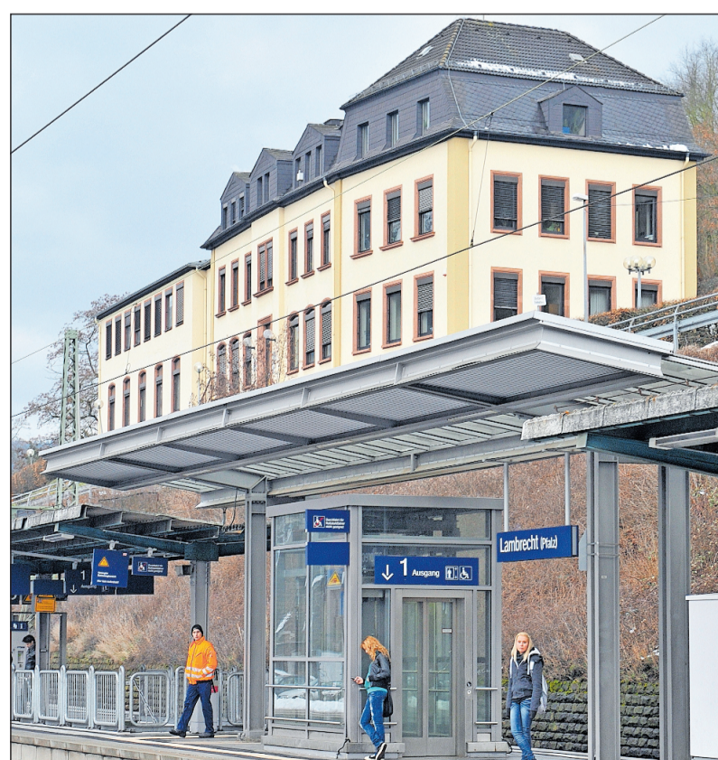
Zurück auf Los: Das Verwaltungsgebäude in Lambrecht. ARCHIVFOTO: LM
